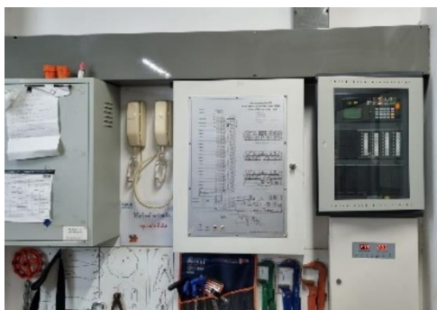
แผงควบคุมระบบแจ้งเตือน รูปที่ 2.1-14 ระบบป้องกันอัคคีภัย (ต่อ)
