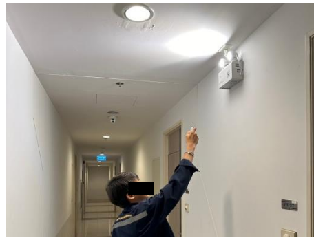
ตรวจเช็คไฟส่องสว่างฉุกเฉิน
