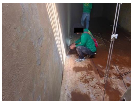
เจ้าหน้าที่ตรวจสอบเช็คถังเก็บน้ำสำรอง/ซ่อมแซมรอยรั่ว
