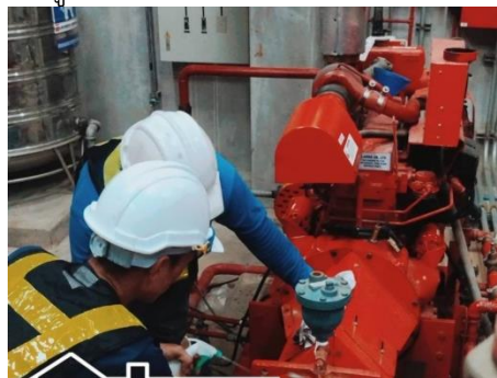
เจ้าหน้าที่ตรวจสอบระบบสูบน้ำดับเพลิง
